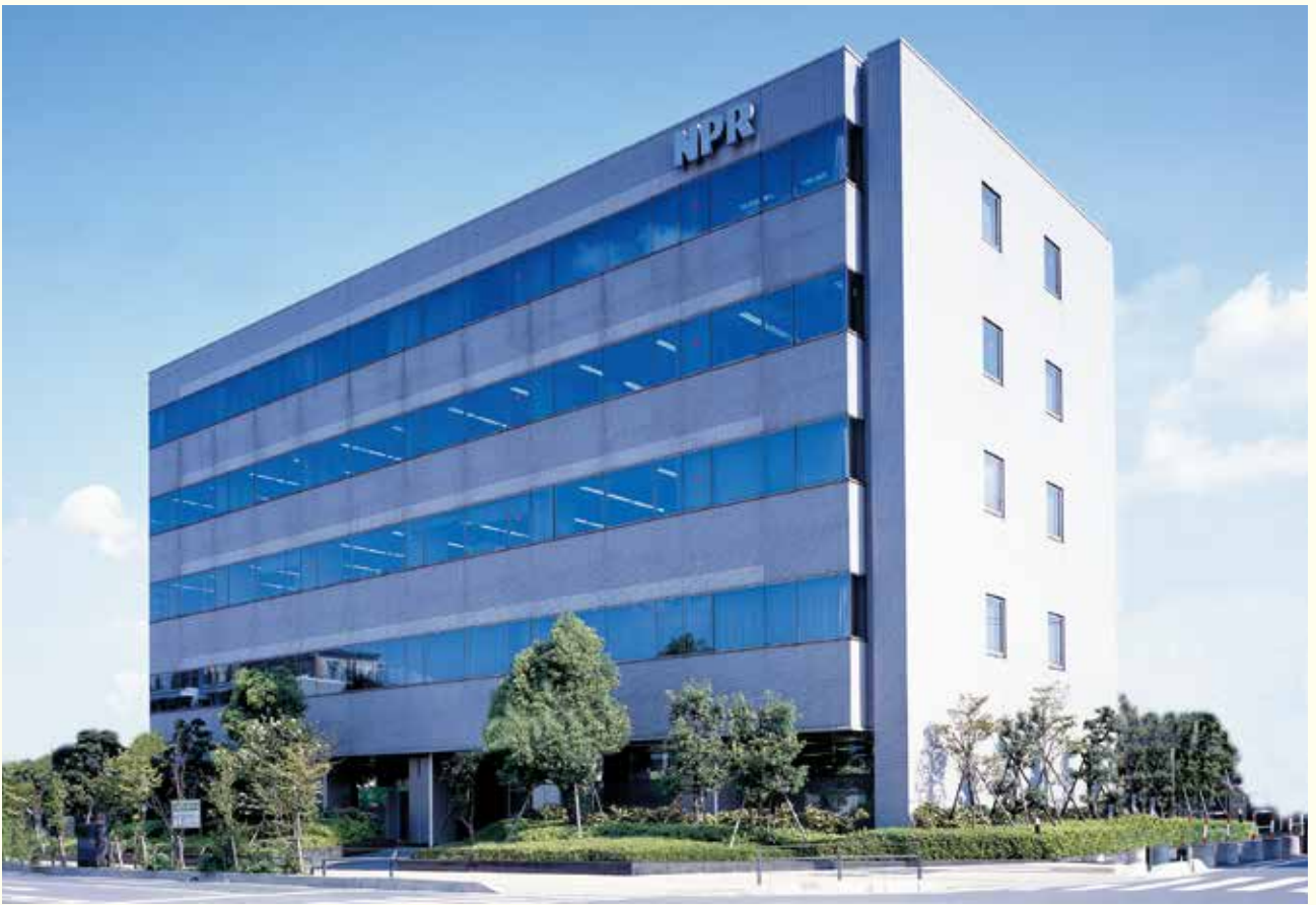
▲Head Office 本社
