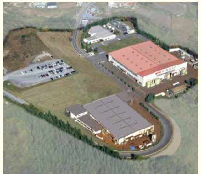
▲NPR Iwate Co.,Ltd./Senmaya Plant (株)日ビス岩手／千厩工場
